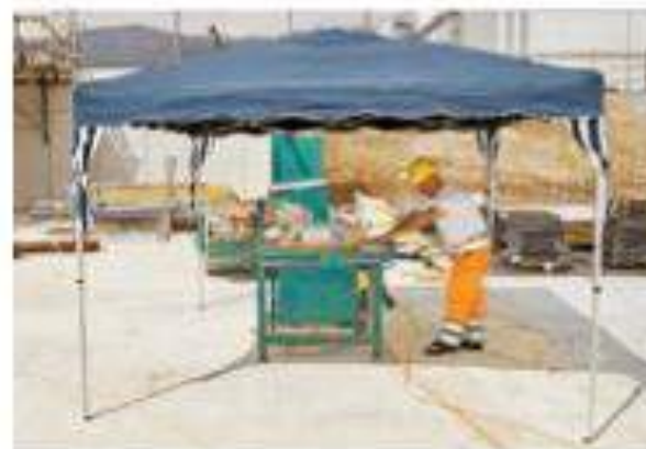
3 Se possibile, ombreggiare i luoghi di lavoro. Si tratta della protezione più efficace.
